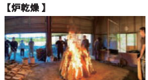
土を練り、炉を築きます。炉が築けると火入れ当日の早朝まで薪を燃やし炉を乾燥させます。
