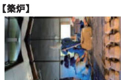
土を練り、炉を築きます。炉が築けると火入れ当日の早朝まで薪を燃やし炉を乾燥させます。
