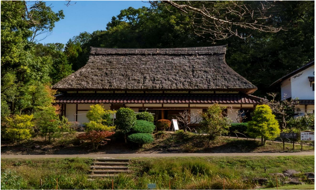
《葺き替え前》 ひばの里 下の農家「茅葺屋根」の様子（2020年10月19日撮影）
