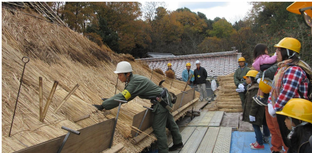
ひばの里「上の農家」茅葺屋根の葺き替えの様子(2018年11月23日撮影)
